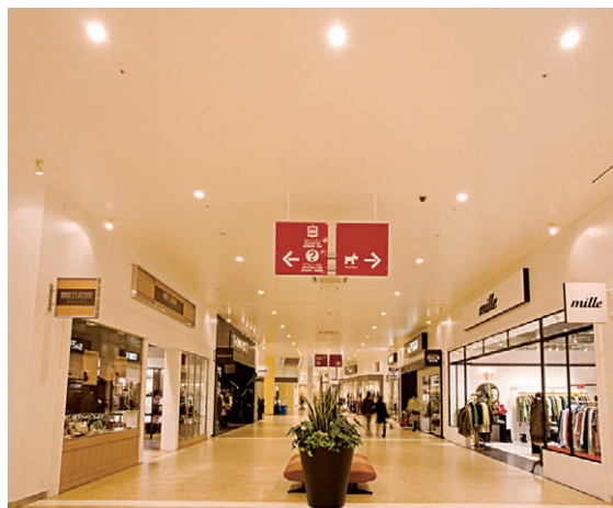
1階共用通路 マスターカラー-CDMダウンライトをベース照明にした1階共用通路の中央部付近。テナントの漏れ光と融和する
