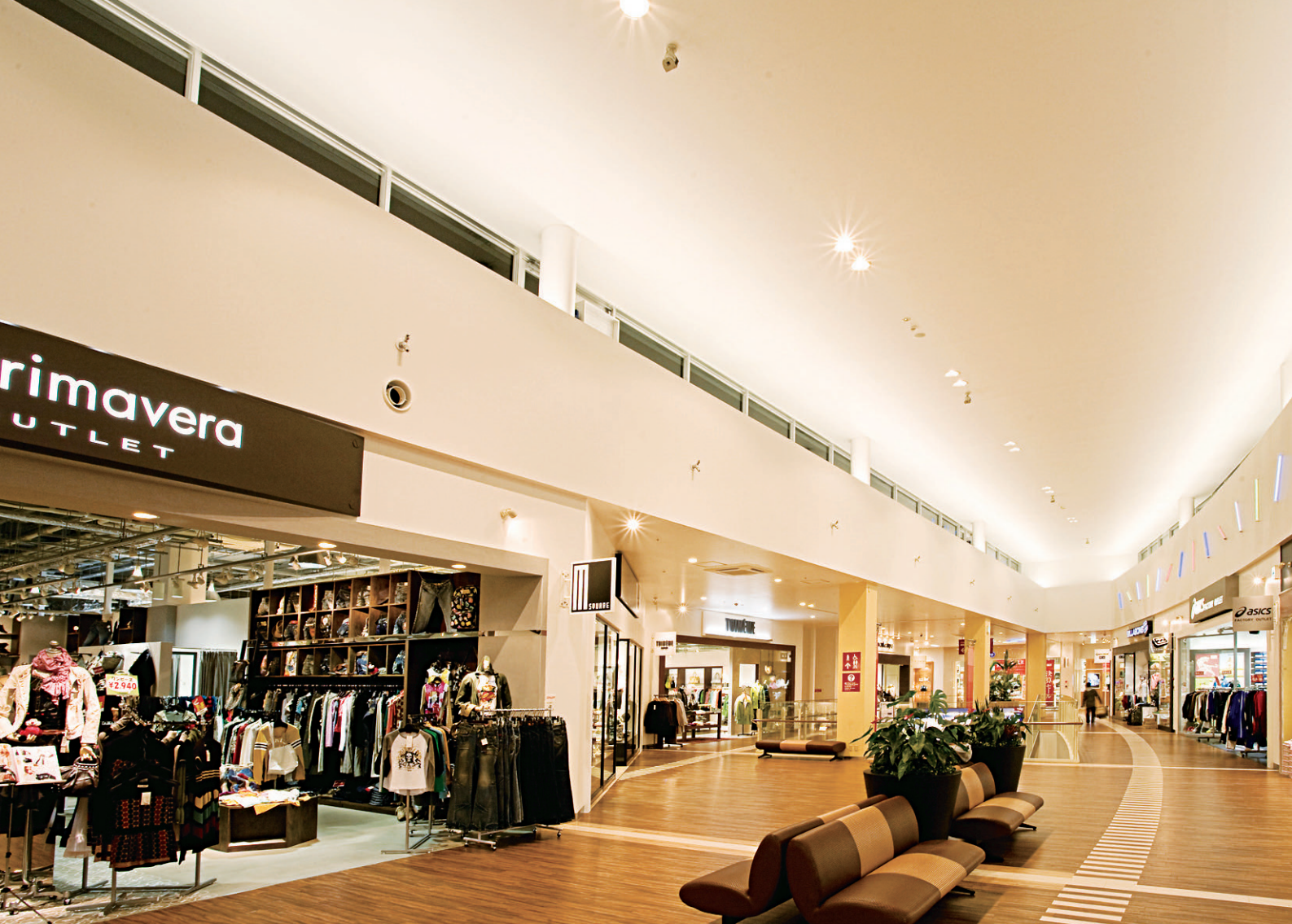
2階共用通路 Hf32W片反射笠器具を天井面に照射するスーパーアンビエント照明により建築空間の輪郭を表現する。地明かりにマスターカラー-CDM150W用ダウンライトを使用
