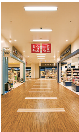
2階通路 連絡口からの通路では、Hf32W2灯用乳白カバー付蛍光灯器具を横配列にして光に変化をつけてモール内に人を誘う
